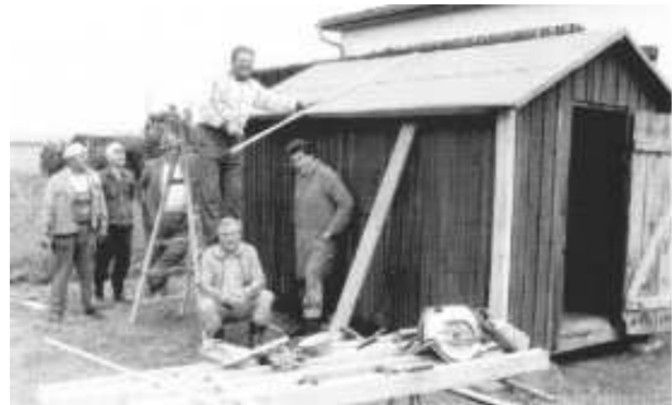
Bau der ersten Gerätehütte 1989
